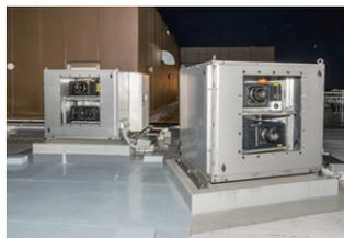
▲ プロジェクターは防塵防水の屋外筐体に格納して上下2段×2基を設置
