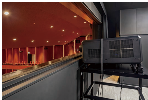
▲ 大劇場の2階客席後方に位置する映写室に設置されたPT-RQ35KJ。30500 lmの高輝度映像で多様な舞台演出をサポート。公演内容によっては映写室から持ち出し、舞台上や天吊りでの設置も実施される。
