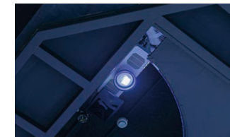
▲PT-RCQ10JLWを天井に2台設置し、床面に投写。
