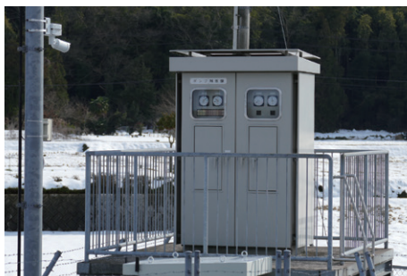
◀ 屋外に設置された若土ポンプ場の計装盤
