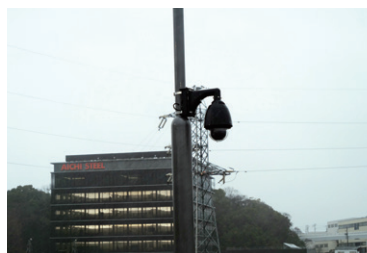
◀ 屋上に設置したPTZカメラも現場の景観にあわせたブラックモデルを採用
