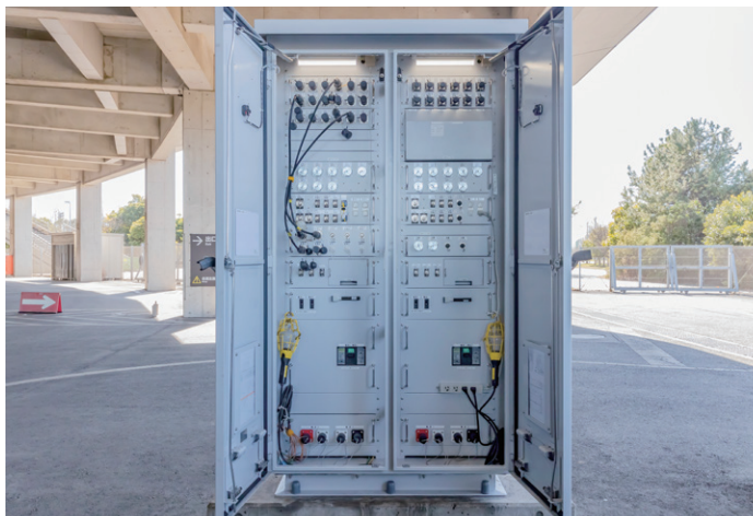
▲TV中継端子盤。ステンレス製の収納架に格納し塩害を防止
