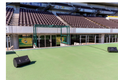
◀ イベント時の仮設用として2ウェイスピーカーWS-AR200-Kも8台導入。複数台使用することでピッチサイドやピッチ内をダイナミックに使った演出が可能
