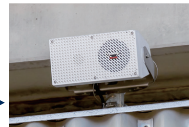
▶スタンドのコンコースに設置された全天候型スピーカーWS-LB301
