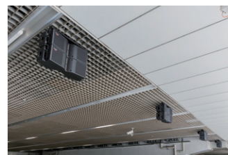
▲ スピーカー11組を天吊りで連続して並べ、イマーシブな音響空間を実現した
