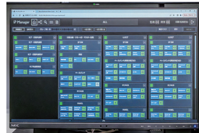
▲ IP機器とベースバンド機器の統合管理・監視が可能なPSS(Panasonic System Surveillance)の画面
