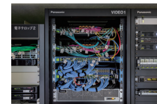
▲ IPシステムの根幹となるメディアスイッチと制御スイッチ
