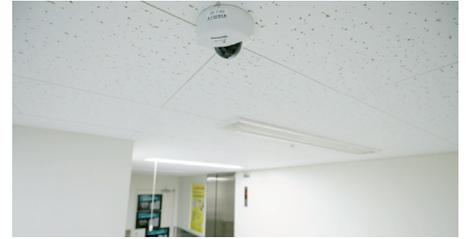
バックヤード通路に設置したドームネットワークカメラWV-SFN130
