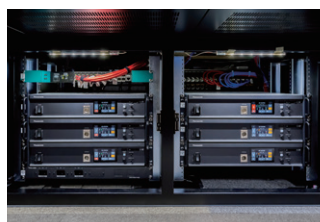
▲ 制作サブにCCUを6台常設。リターンがIPで4系統入る点が好評。それらの割り当てはPSMから設定可能
