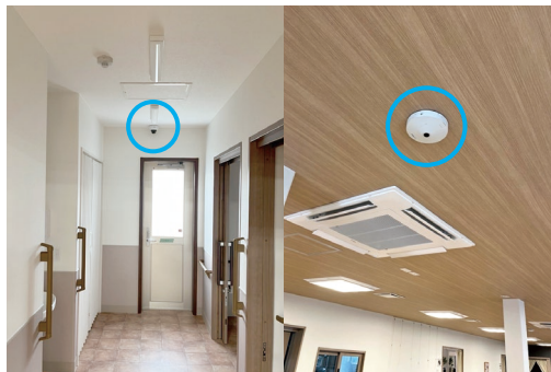
▲ 通路を見守るツクイ市川宮久保のドームカメラ(写真左)とフロアを見守るツクイ武蔵村山の全方位カメラ(写真右)
