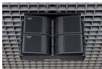
▲ 音響には防滴型のRAMSAラインアレイスピーカーを2台1組で活用
