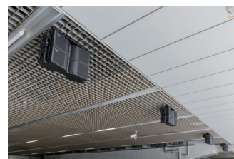
▲ スピーカー11組を天吊りで連続して並べ、イメージ的な音響空間を実現した
