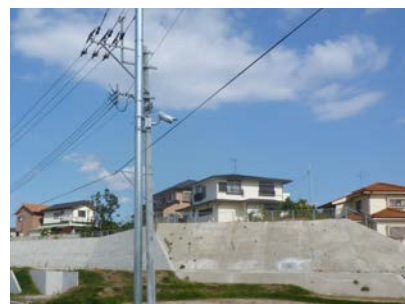
建設中のコットンヒルズ桧原公園通り
