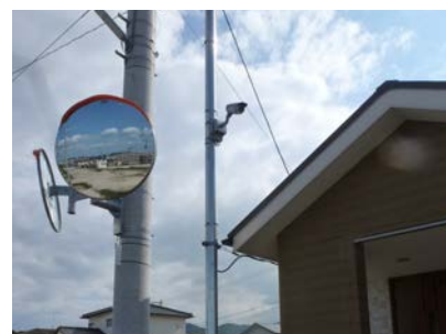
設置された監視カメラ
