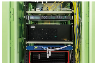
▲ データセンター内のIOWN APNへ接続されたKairos Core(ラック中央)
