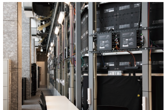
▲ 軽量・薄型設計のため、バックヤードのスペースを圧迫することなく設置可能
