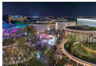
▲ 木造プレハブとレンタルスチールで作られたパピリオンの夜景。ここで初めて使われた素材もある
