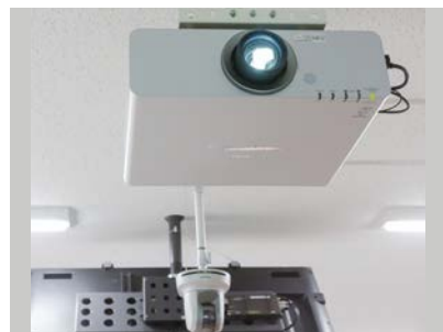
天井面に設置されたプロジェクターとHDカメラ。HDカメラは2台設置し、講義収録やTV会議に使用
