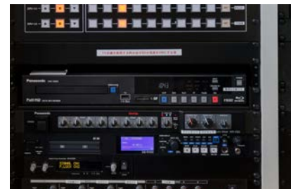
コントローラーのボタン操作により、プロジェクターの映像選択や電動スクリーン操作が可能
