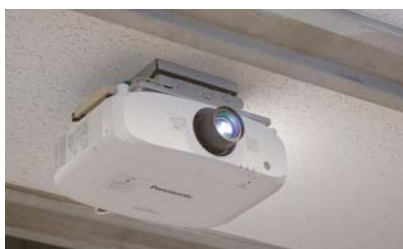
天井に設置されたプロジェクター
