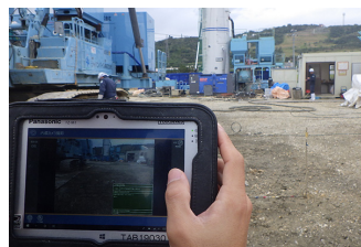
▲スナップショット機能を使用すれば、撮影した現場を杭工事記録システム現場検査マイスター®に取り込むことができる
