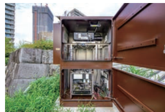
▲ プロジェクターや制御機器を納めた筐体。外壁には遠隔監視用のカメラを設置
