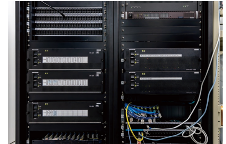
▲Sサブの隣のラック室にはSDI信号をIP信号に変換するIP-GW (AV-PF80GW1)を設置。Nサブにも同様の構成で設置されている
