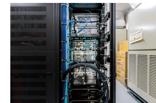
▲ フルIPでシンプルな配線を実現したAV-HS8300メインフレーム背面の様子
